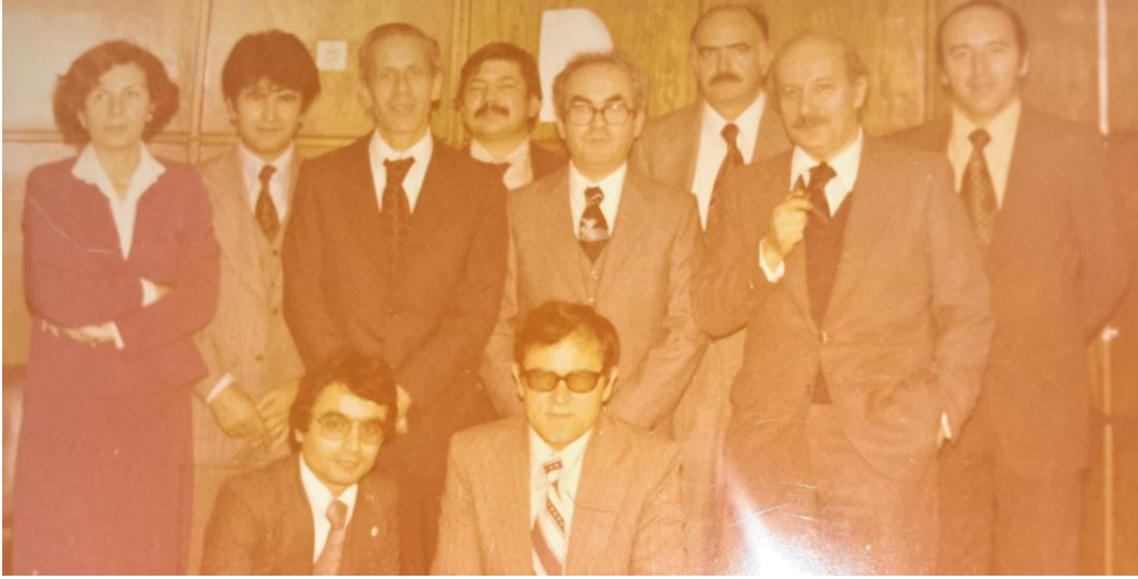
Beşiktaş Kampüsü (Mimarlık Fak. olarak kullanılan Blok), Yapı Çalışma Grubu (1980)
