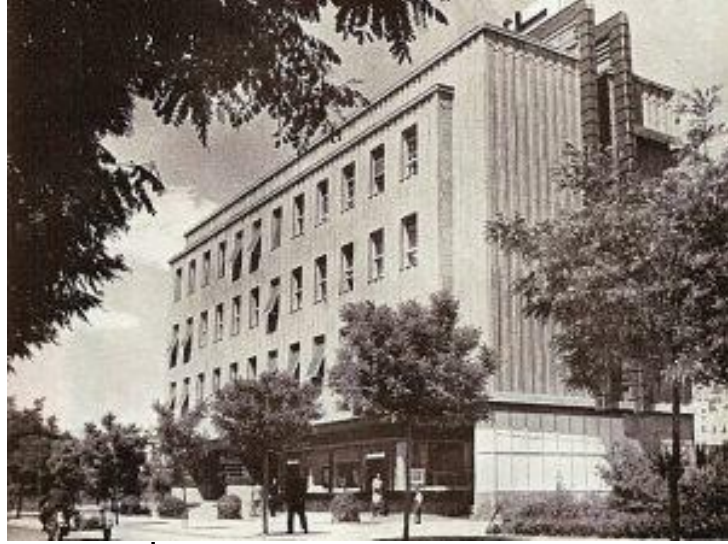
Şekil 3.26 İller Bankası Genel Müdürlüğü eski binası
